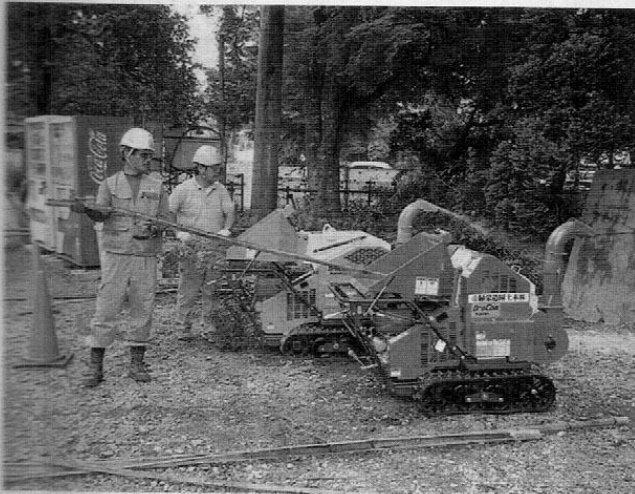
現場での粉碎作業の様子
